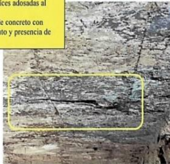
Figura 5 Losa de concreto (superficie inferior).
