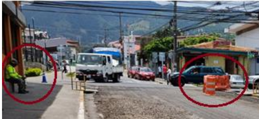
Imagen 11. Vía en proceso constructivo sin control vehicular.
