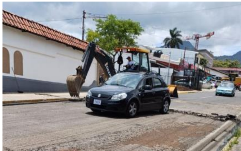
Imagen 8. Equipo especial trabaja con la vía abierta al tránsito.
