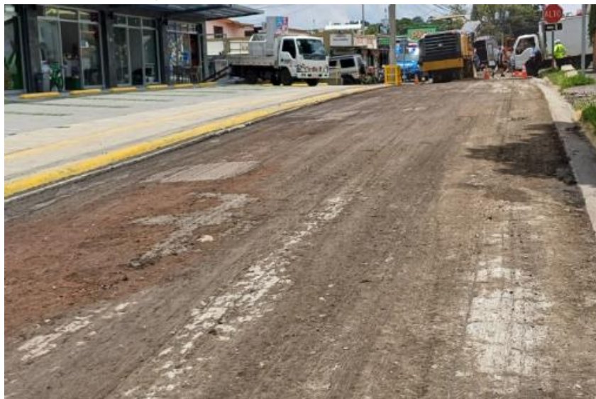
Imagen 1. Calle a la cual se le removió la carpeta existente.
