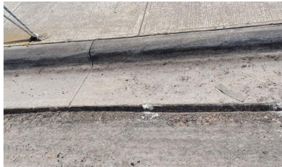
Imagen 12. Cordón y caño y buenas condiciones
