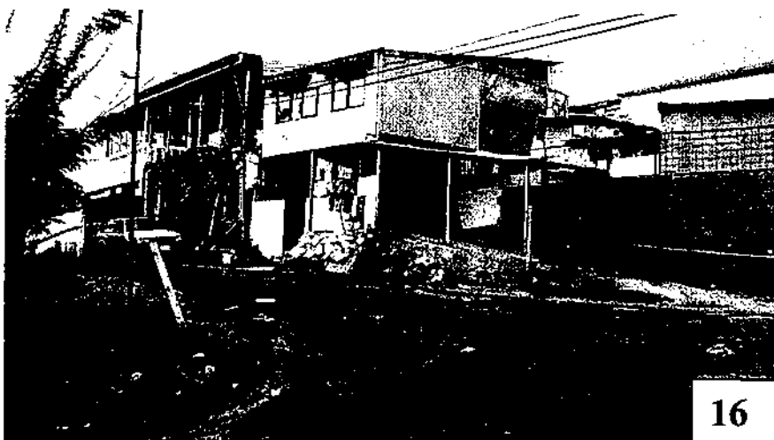
Foto No.16: 04/08/2009 Uso urbano intenso con problemas de discurrimiento de aguas pluviales y aguas negras. Barrio El Carmen, sector central de la ZAA
