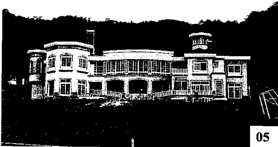
Foto No.5: 28/07/2009 Impermeabilización del suelo por altos porcentajes de cobertura edificatoria permitida y desestabilización de laderas por movimientos de tierra. Construcción de casa de habitación en etapa de acabados en Alto Carrizal, sector oeste de la ZAA.
