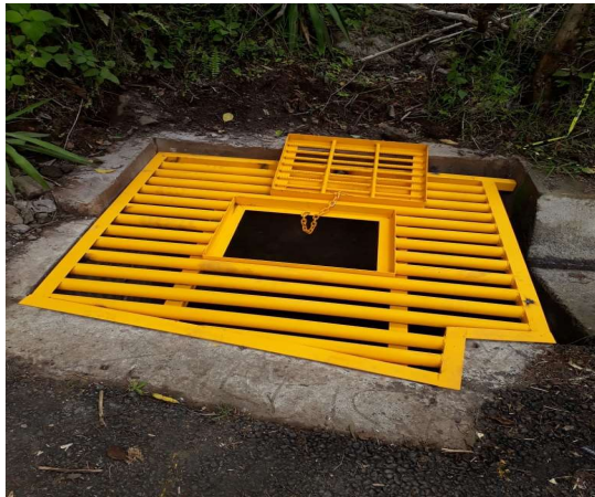
Calle Raicero: Confección de parrilla y limpieza en la caja de registro.
