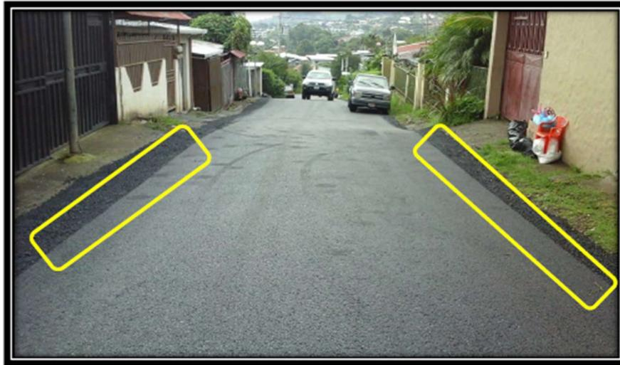
Imagen N° 2: Falta de infraestructura para control de aguas en extremos de la vía
