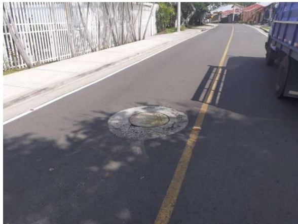
Reparación de Tapa de Alcantarilla
