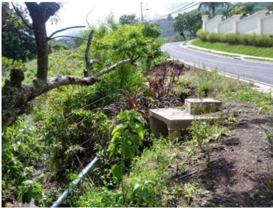
Caída de Material en Alto de Carrizal
